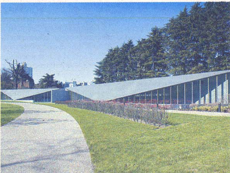
Το κτίριο του «21-21 Design Sight» έχει σχεδιάσει ο διάσημος αρχιτέκτονας Ταντάο Αντο . Ο ίδιος τονίζει ότι «ένα ενιαίο αστάλινο φύλλο, μήκος 54 μέτρων, αποτελεί τη στέγη συμβολίζοντας το προηγμένο στάδιο όπου βρίσκεται η ιαπωνική τεχνολογία»
